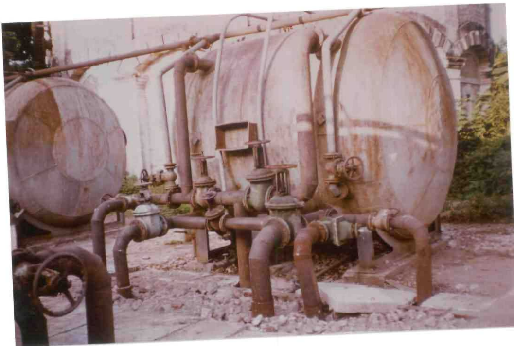
NOUVELLE UNITE DE FILTRATION EN CONSTRUCTION (p25)
